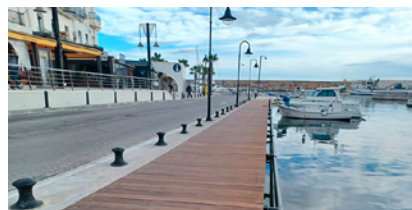
Un tram de passarel·la de fusta reparada al port de l'Ametlla de Mar
